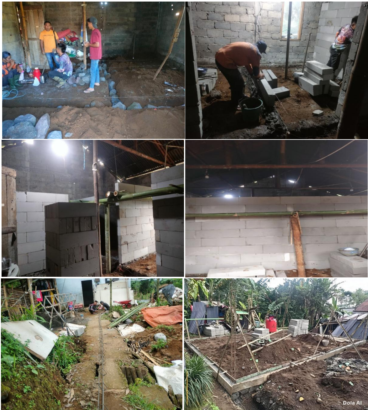
Gambar 12. Pembangunan Rumah Tidak Layak Huni (RTLH) PKE 2026
